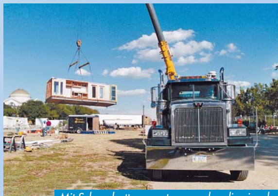
Mit Schwerlasttransportern werden die einzelnen Module in die Vereinigten Staaten verfrachtet.
